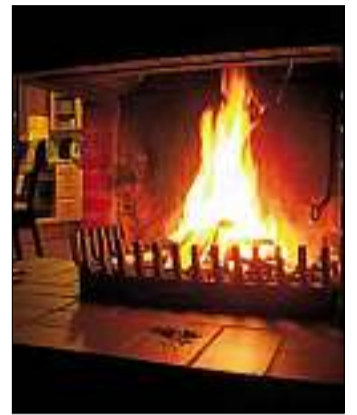
Ideal sind ein Gitter rund ums Cheminée und ein nicht brennbarer Steinboden. (zvg)
